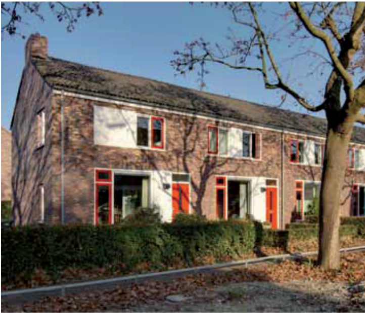
De wijk heeft een fris aanzicht gekregen door innovatieve renovatie met keramische steenstrips. Decoratieve profielen rond de kozijnen maken de transformatie visueel af.
