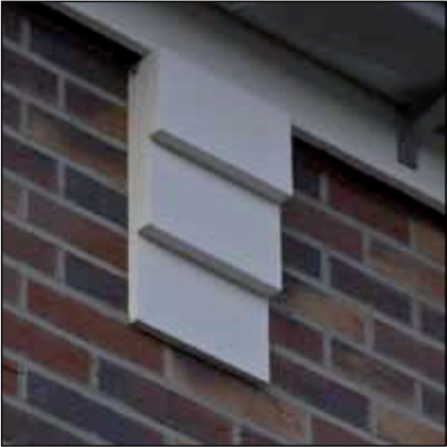
Aansluiting tegen dakrand
