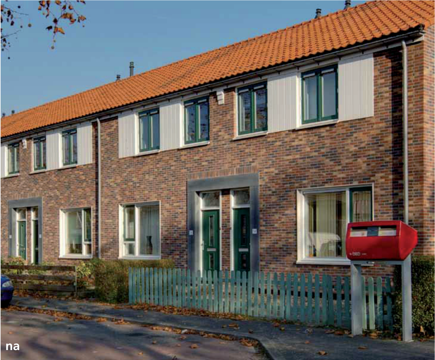
Met de totale schilrenovatie hebben de woningen een upgrade gekregen van een G-label naar een B-label zonder verlies van de originele uitstraling. (foto's: op ten noort blijdenstein architecten en adviseurs)
